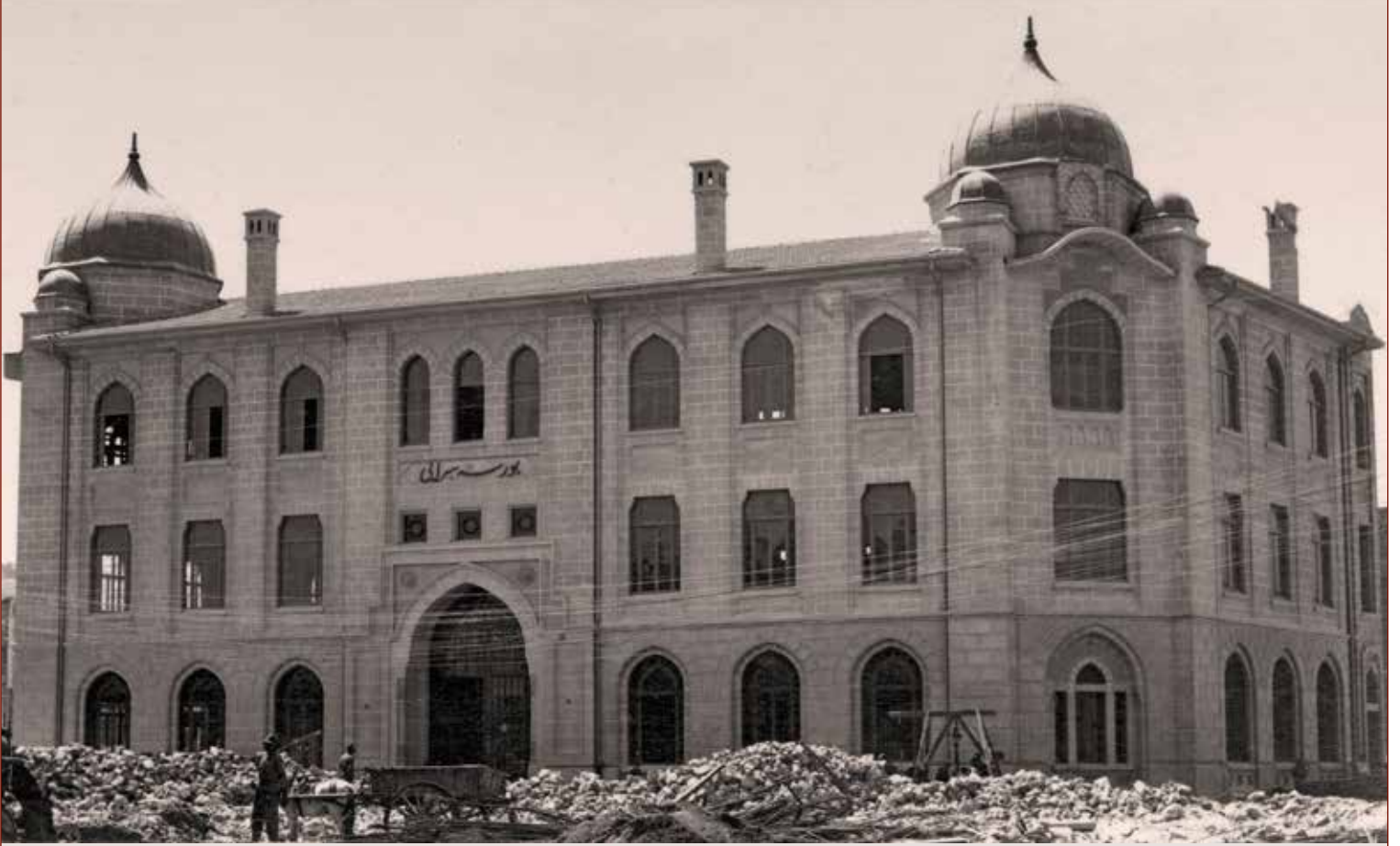
İzmir Ticaret Borsası binası, 1928 (İTB arşivi)
